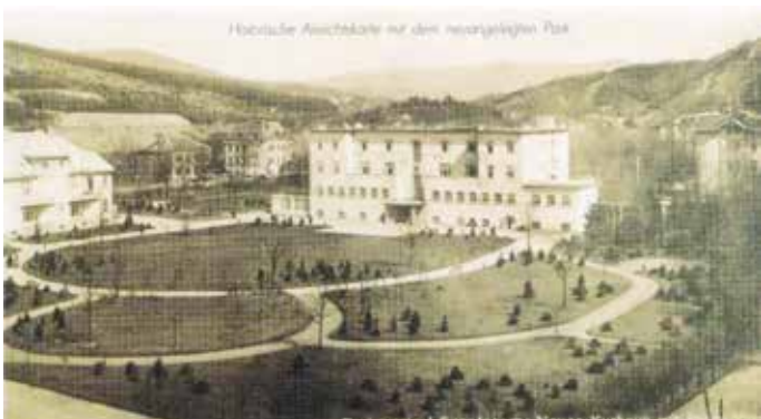
Historische Ansicht Parkfläche
